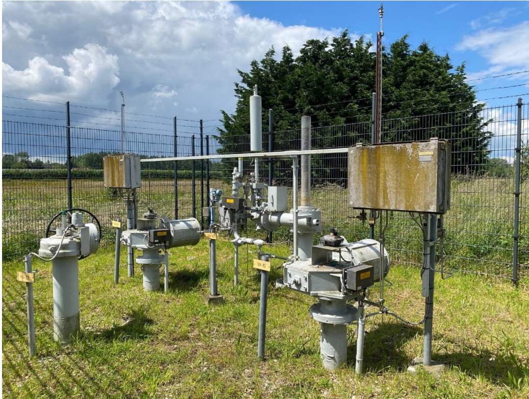
Afbeelding 2.2 Voorbeeld van een afsluiterlocatie
