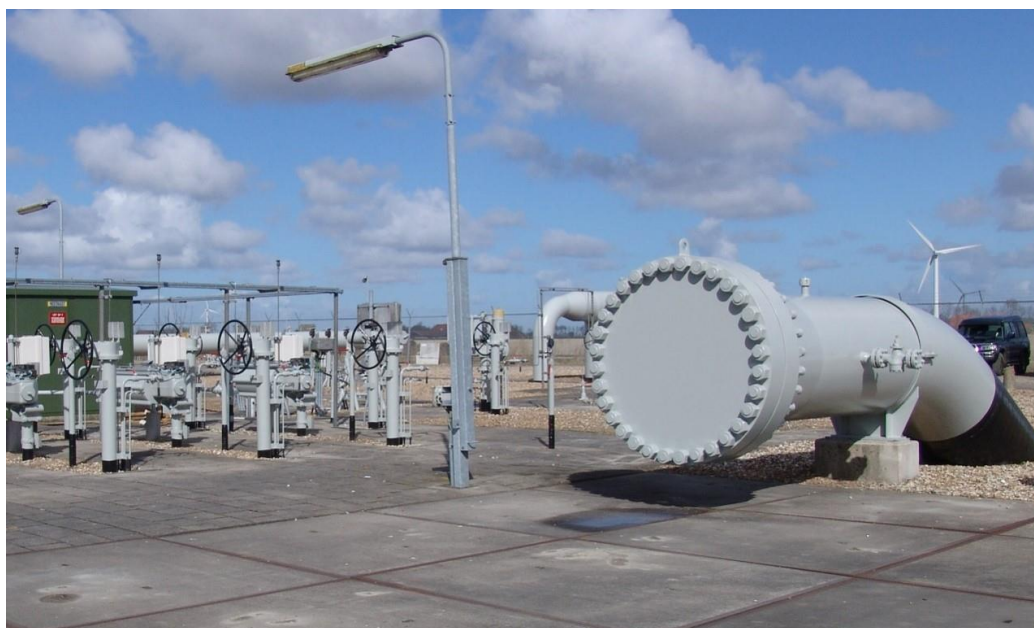
Afbeelding 2.3 Scraper trap (rechts op de foto)
